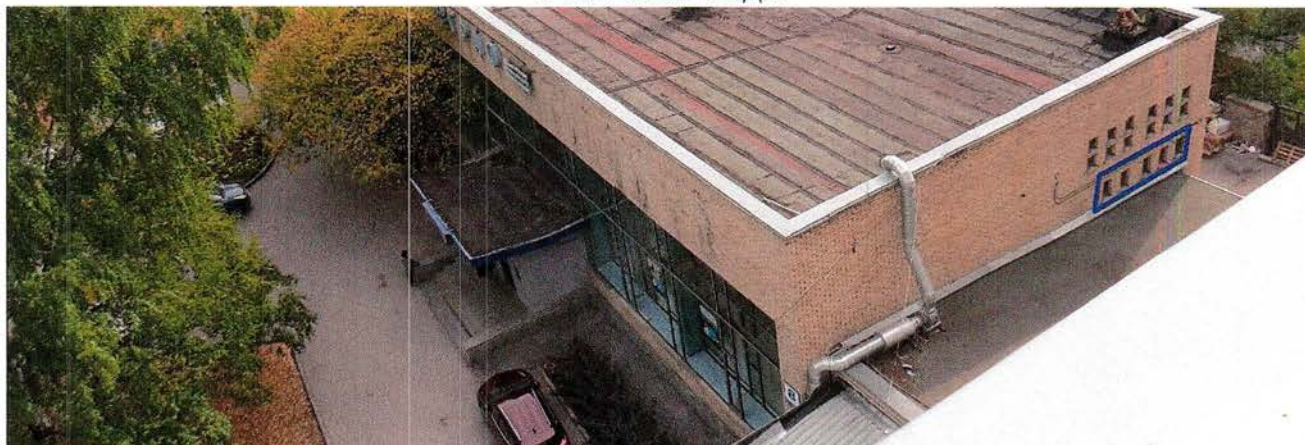
Северо-западный фасад. Окна лестничной клетки. Фото 2016 года.
